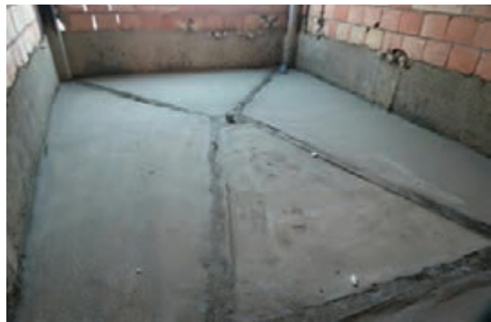
اجرای کرم و بتن شیب‌بندی حمام
