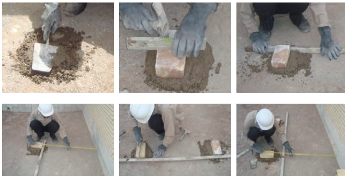
مراحل تعیین محل جداکننده
