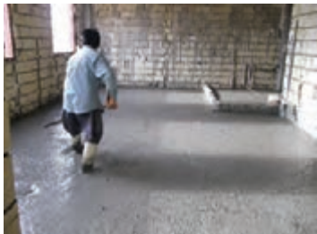
تسطیح فوم بتن قبل از خشک شدن
