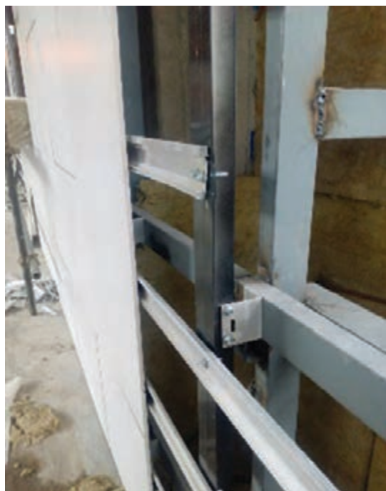
نمایی از اتصال قطعه به زیرسازی
