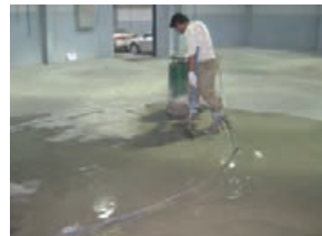
اجرای ملات برای مسطح کردن سطح
