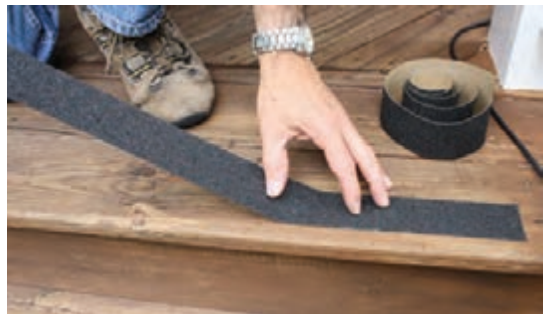
نصب ورقه‌های زبر برای پیشگیری از سر خوردن افراد
