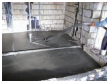
اجرای فوم بتن به عنوان بتن کف‌سازی
