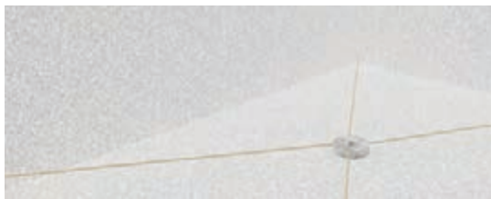
مرحله ۳- ریسمان‌کشی و تنظیم شیب مورد نظر به وسیله ریسمان‌ها
