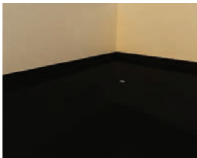
۲- اجرای قیر روی بتن شیب بندی
