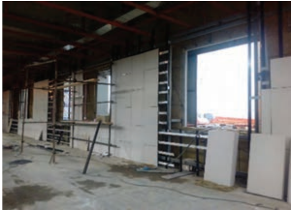
اجرای زیرسازی فلزی
