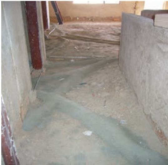
پوشش تأسیسات به منظور محافظت از آنها
