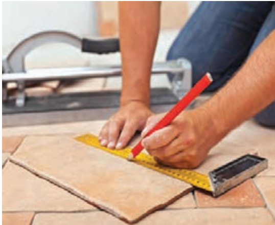
مشخص کردن مسیر برش سرامیک
